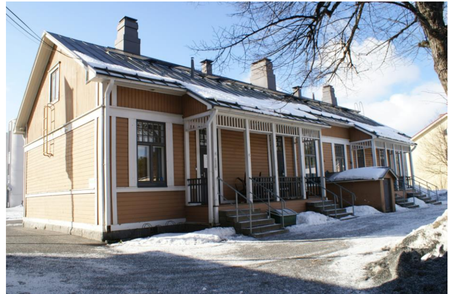
Kuva: Puutalon pihafasadi, jossa on kaksi avokuistia ja kellarin sisäänkäynti.
