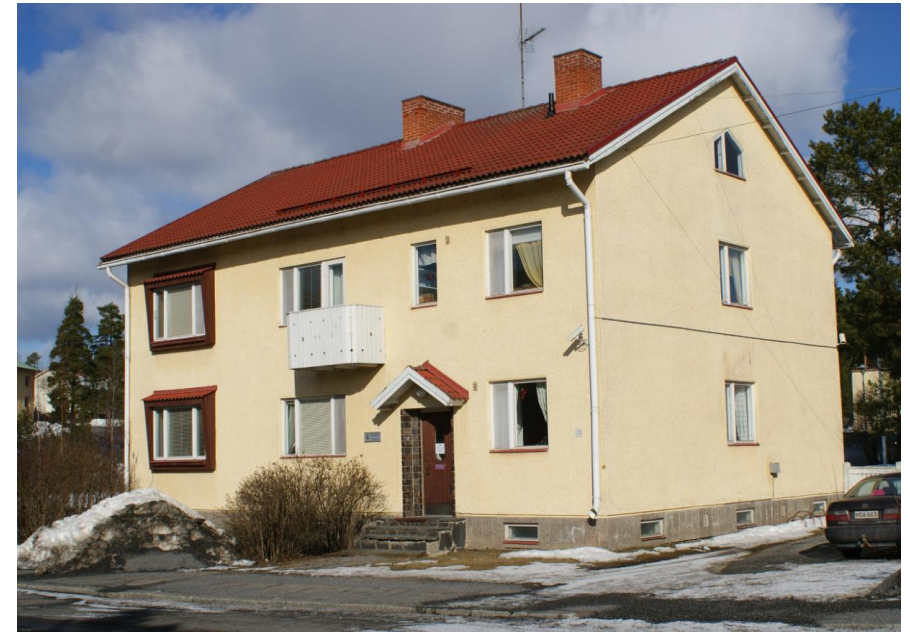
Kuva: Puutalon pihafasadi, jossa on kaksi avokuistia ja kellarin sisäänkäynti.
