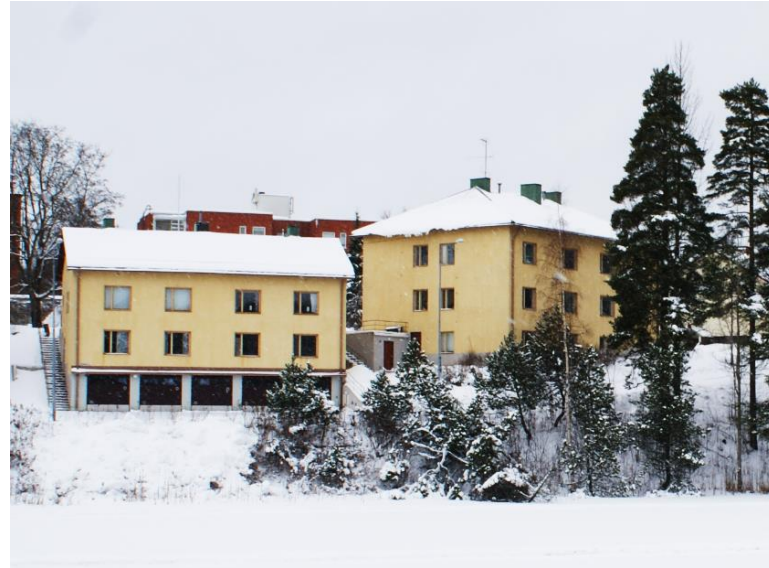
Kuva: Yrjönkatu 22 sijaitsee Myrkkylammen länsirannalla.
