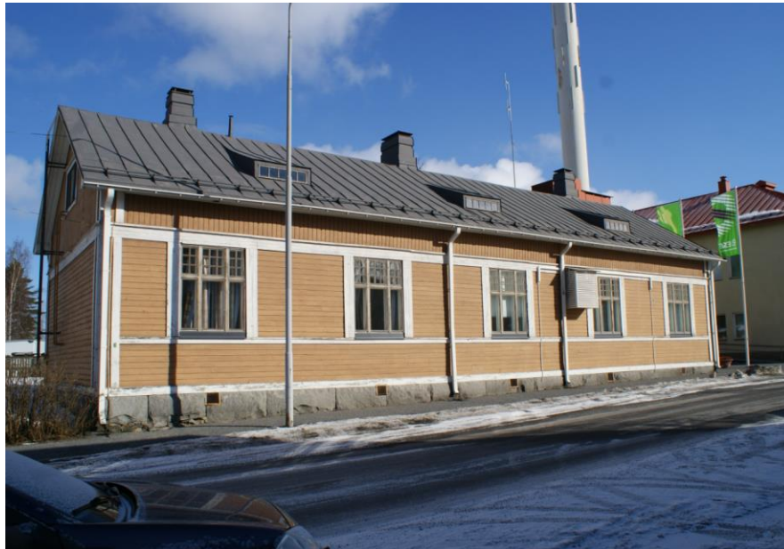
Kuva: Puutalon kadunpuoleinen julkisivu on säilynyt tyyllisesti ennallaan. Rännit ja syöksytorvet sekä ilmalämpöpumpun ulkoyksikkö ovat myöhempää kerrostumaa.
