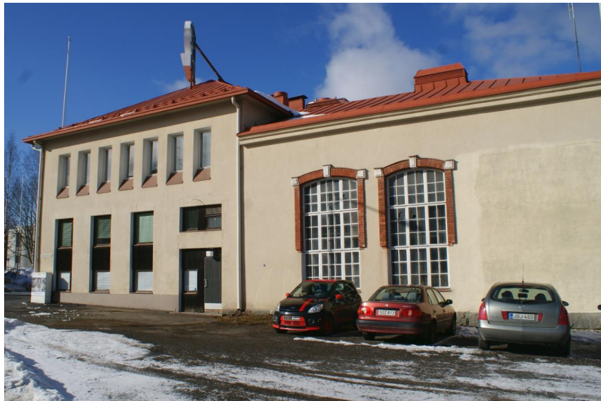
Kuva: Vanhan kattilahuoneen pieniruutuiset ikkunat ovat rakennuksen koristeellisin yksityiskohta.
