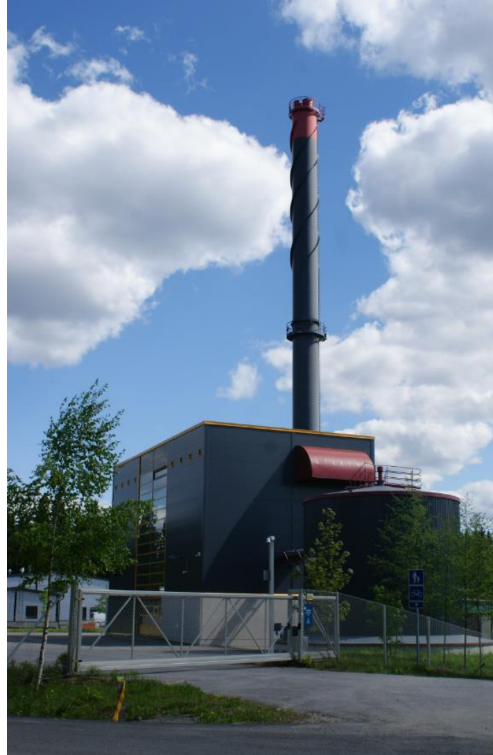
Kuva: Rokkalan lämpökeskus valmistui vuonna 2004.
