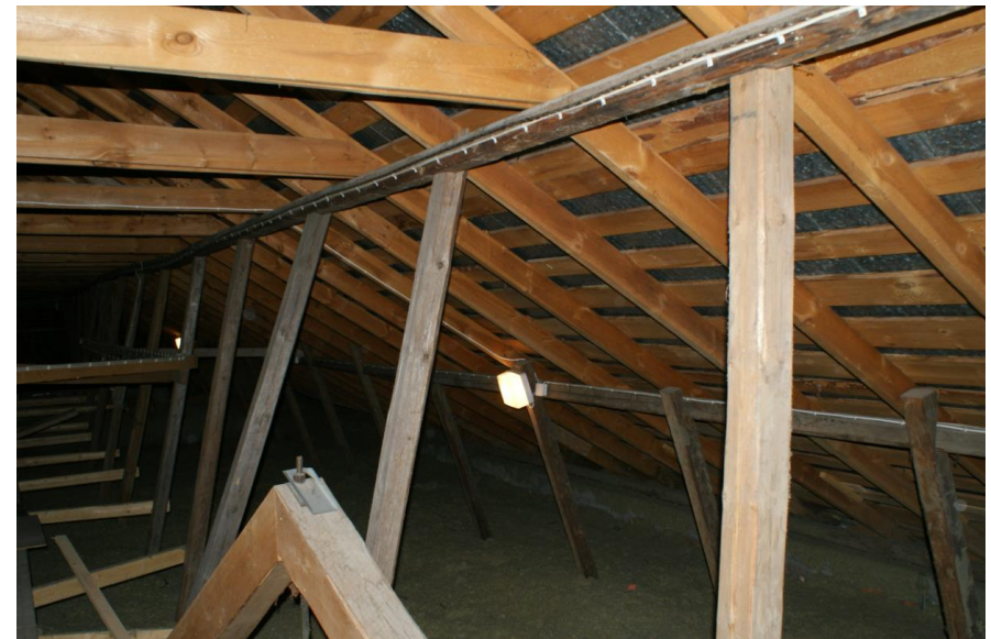
Kuva: Ullakolla näkyviä katto-rakenteita 1940-luvulta. Osalle yläpohjaa on eristeeksi vaihdettu puhallusvilla.
