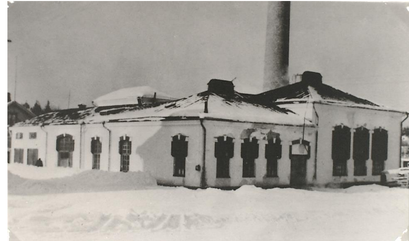
Kuva: Sähkölaitos vuonna 1946 ennen rakennustöiden alkamista. Sitten 1910-luvun laajennusten, vuonna 1931, oli rakennusta jatkettu kahta kuorma-autoa varten tehdyllä autotallilla. Tilat vasemmalta oikealle: autotallit, myymälä, turbiinihuone ja kattilahuone./ ESEn valokuvat.
