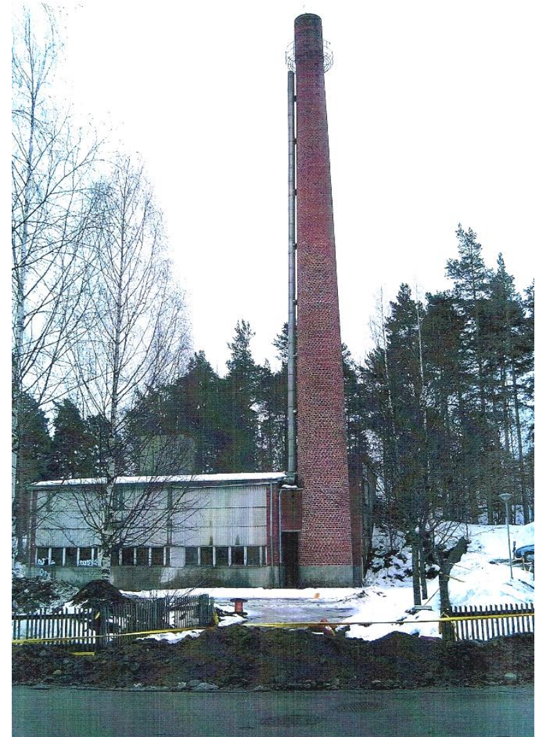
Kuva: Vuonna 1978 Kiiskinlämpö Oy lakkautettiin ja yhdistettiin pääverkkoon lämmönsiirtimellä. Vuonna 1995 Kiiskinmäen lämpökeskus jäi pois käytöstä ja kattila siirrettiin Oravinmäen lämpökeskukseksi Olavi Räsänen Oy:n tehdasalueelle. Kiiskinmäen lämpökeskus ja sen tiilipiippu on sittemmin purettu ja tilalle rakennettu kerrostalo. / ESEN valokuvat.
